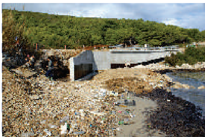
Slika 16. Građevinski radovi pored pješčane plaže u Milni. Zemljom i kamenjem nasuta je gotovo polovica plaže.
